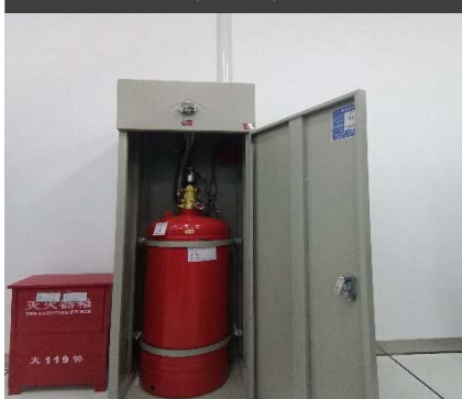
資訊機房新增七氟丙烷自動滅火系統
